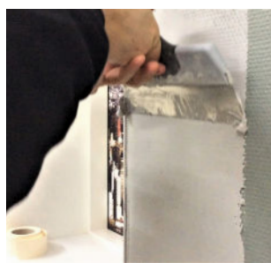
Påfør 1 mm spartelmasse
